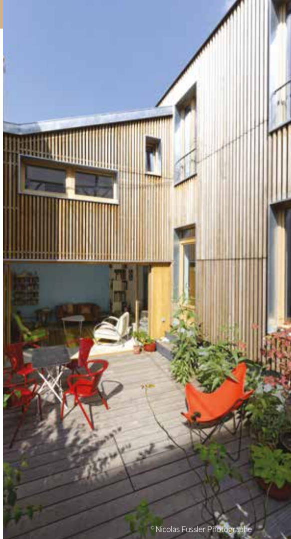
Pré St-Gervais (75) — Bardage en peuplier THT Côtéparc® Verdier-Rebière Architectes
