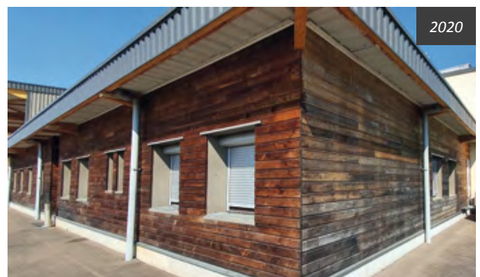
Face sud à gauche (chêne THT). Face est à droite (peuplier THT)
