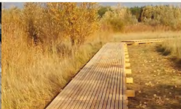
PLATELAGE ACACIA Avec pieux de 6 m dans un parc naturel
