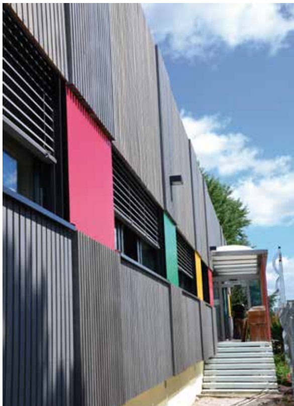
Cetic (71) — Bardage en peuplier THT – Finition Rubio Monocoat® gris vieux bois – Architecte Olivier Le Gallée / THT poplar cladding - Rubio Monocoat® old wood grey finish - Architect Olivier Le Gallée
