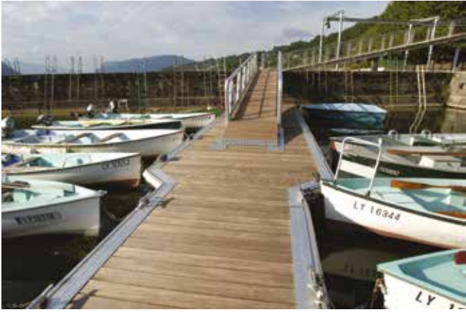
Ponton du Lac du Bourget (73) — Platelage chêne naturel classe 4 / Class 4 natural oak decking
