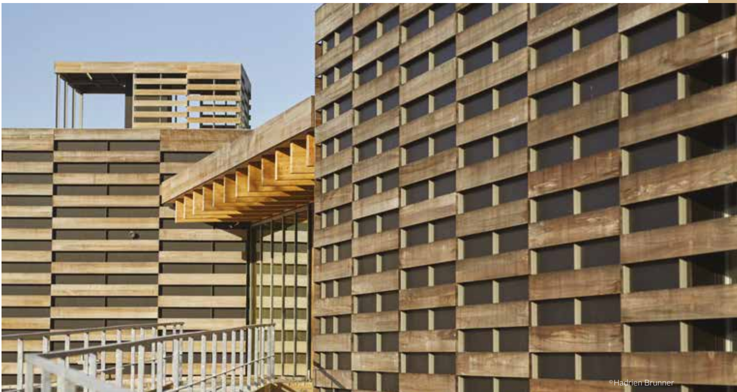
Centre terre d'estuaire (44) — Bardage en peuplier THT/ THT poplar cladding Bruno Mader architectes
